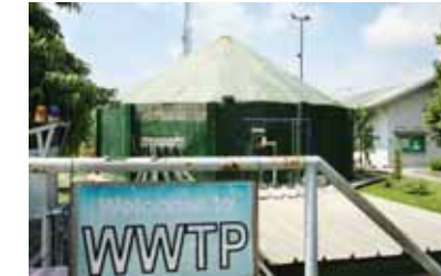
Instalasi pengolahan air limbah di Sarihusada. Pada tahun 2011 kuantitas air limbah yang dialirkan mengalami penurunan karena efisiensi penggunaan air dan upaya daur ulang air limbah.
